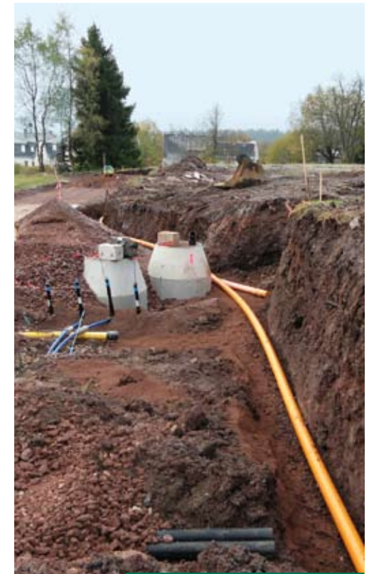
Oberhof, „Oberer Schloßberg“, Erschließungsarbeiten für zukünftige Wohnbebauung
