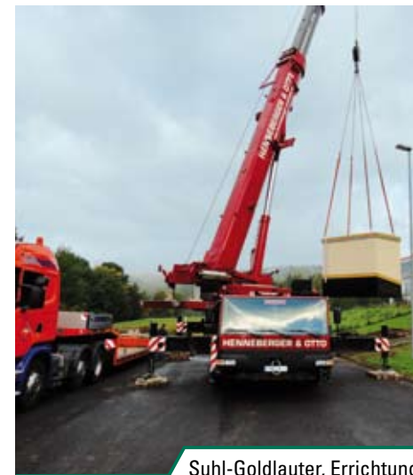
Suhl-Goldlauter, Errichtung einer neuen Ortsnetzstation
