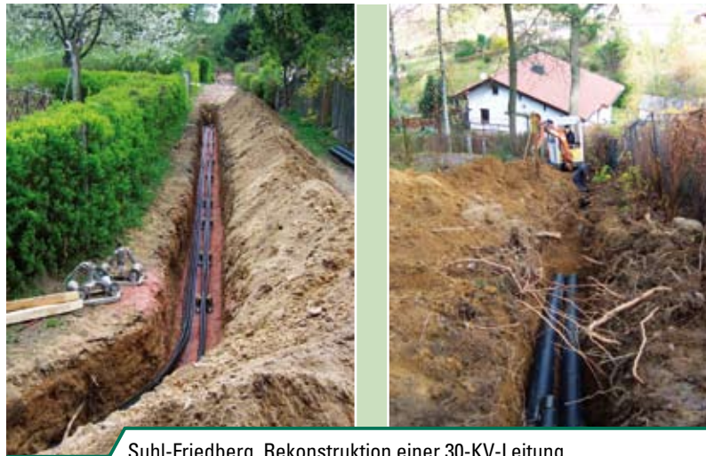
Suhl-Friedberg, Rekonstruktion einer 30-KV-Leitung
