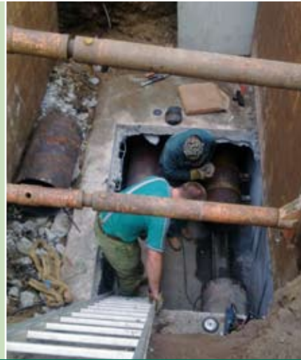
Suhl, Ilmenauer Straße, Baustelle zur Störungsbeseitigung an der Primärtrasse zur Fernwärmeversorgung durch Neuverlegung von Rohren 2 x DN 40
