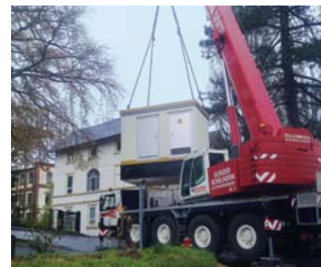
Zella-Mehlis, Haseneystraße, Errichtung einer neuen Ortsnetzstation
