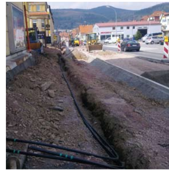
Suhl, Blücherstraße/ Neubauerstraße, Rekonstruktion von Nieder- und Mittelspannungsleitungen
