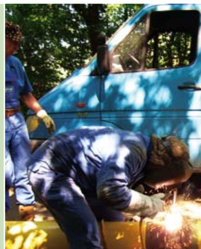
Suhl, Am Sehmar, Erneuerung der Hochdruckgasleitungen
