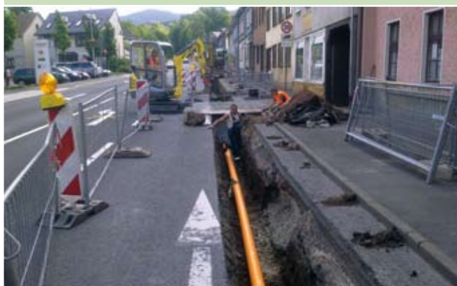
Zella-Mehlis, Oberhofer Straße, Rekonstruktion des Ortsnetzes, Neuverlegung der Niederspannungskabel und der Niederdruckgasleitungen sowie Erneuerung aller Hausanschlüsse
