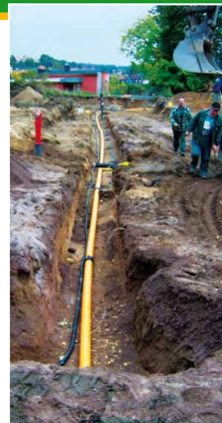
Zella-Mehlis, Ansorgstraße, Eit- und Gaserschließung für zukünftige Wohnbebauung
