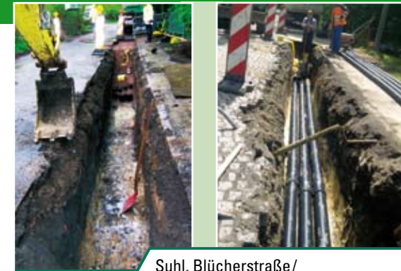
Suhl, Blücherstraße/ Neubauerstraße, Rekonstruktion von Nieder- und Mittelspannungsleitungen
