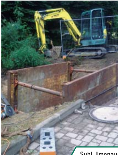
Suhl, Ilmenauer Straße, Baustelle zur Störungsbeseitigung an der Primärtrasse zur Fernwärmeversorgung durch Neuverlegung von Rohren 2 x DN 40
