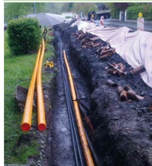
Zella-Mehlis, Haseneystraße/ Feldgasse, Neuverlegung von Mittelspannungskabeln und Mitteldruckgasleitungen
