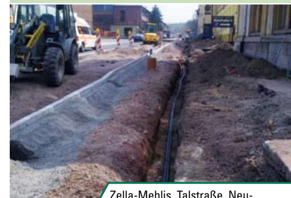
Zella-Mehlis, Talstraße, Neuverlegung von Mittelspannungsleitungen im Zuge des grundhaften Ausbaus der Bundesstraße B 62
