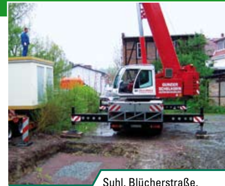
Suhl, Blücherstraße, Errichtung einer neuen Ortsnetzstation
