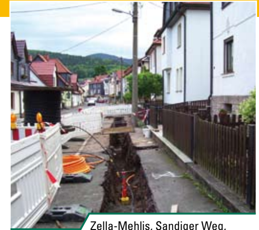
Zella-Mehlis, Sandiger Weg, Neuverlegung der Mitteldruckgasleitung und aller Hausanschlüsse
