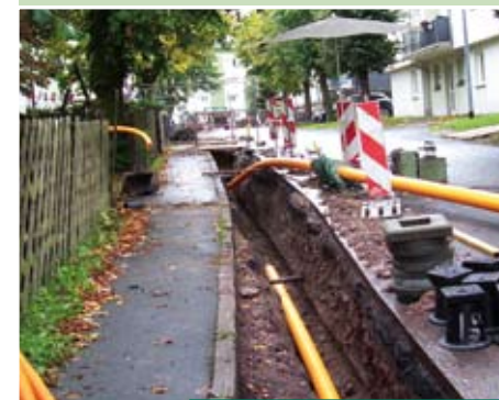
Oberhof, Jägerstraße/Neue Straße, Neuverlegung der Mitteldruckgasleitung
