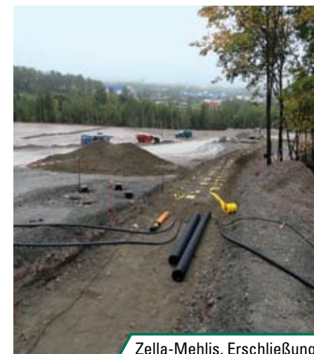
Zella-Mehlis, Erschließung des Industrie- und Gewerbegebietes „Ost“, 5. Bauabschnitt
